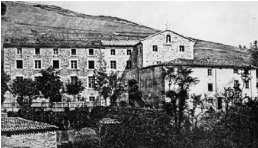
La cuna del Instituto y el internado del H. Vincent que se unió a la capilla (1886)
