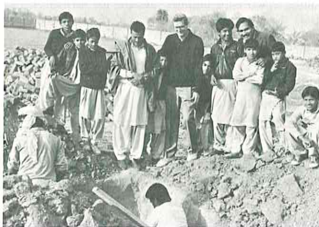
Sargodha: preparando los cimientos para la construcción
