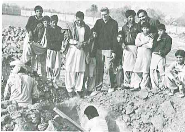
Sargodha: début des travaux de construction
