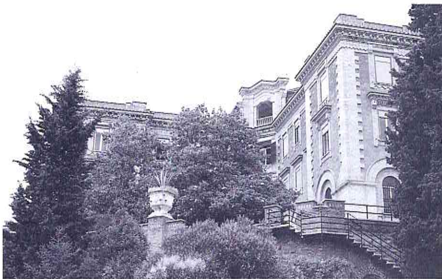
Maison Générale des Pères maristes à Rome (vue postérieure).
