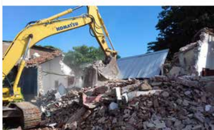
Mexique: Démolition de la maison Mariste de Asunción Ixtaltepec, Oaxaca
