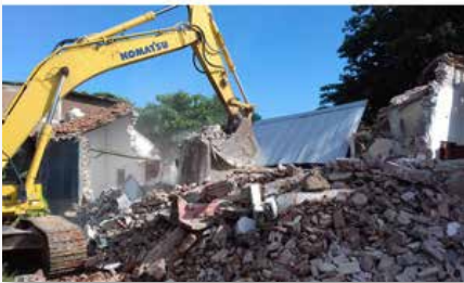
México: Demolição da casa Marista de Asunção Ixtaltepec, Oaxaca
