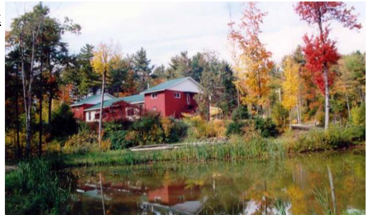
La construction du chalet Larocque a eu lieu en 1994-95
